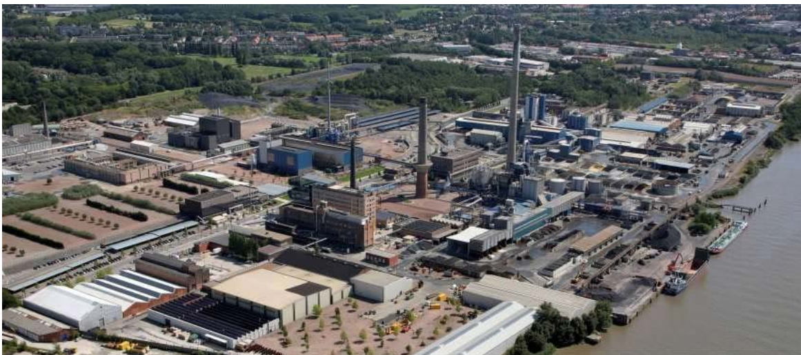
Abbildung 37 Umicore's integrierte Metallhütte in Hoboken/Antwerpen. Mit einer Eingangsmenge an Sekundärmaterial von 350.000 t / Jahr ist sie die weltweit größte Recyclinganlage ihrer Art; [Hagelücken, Treffer 2011]
